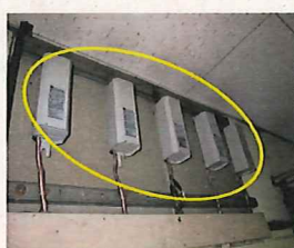
工場等の壁際に設置されてい る複数の安定器の例
